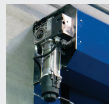
Motor reductor acoplado al bastidor
