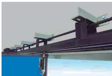
Detalle de la guía superior específicamente fabricado para cada puerta en particular.
