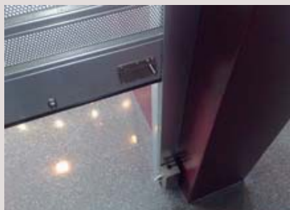
Pestillos electromecánicos.
