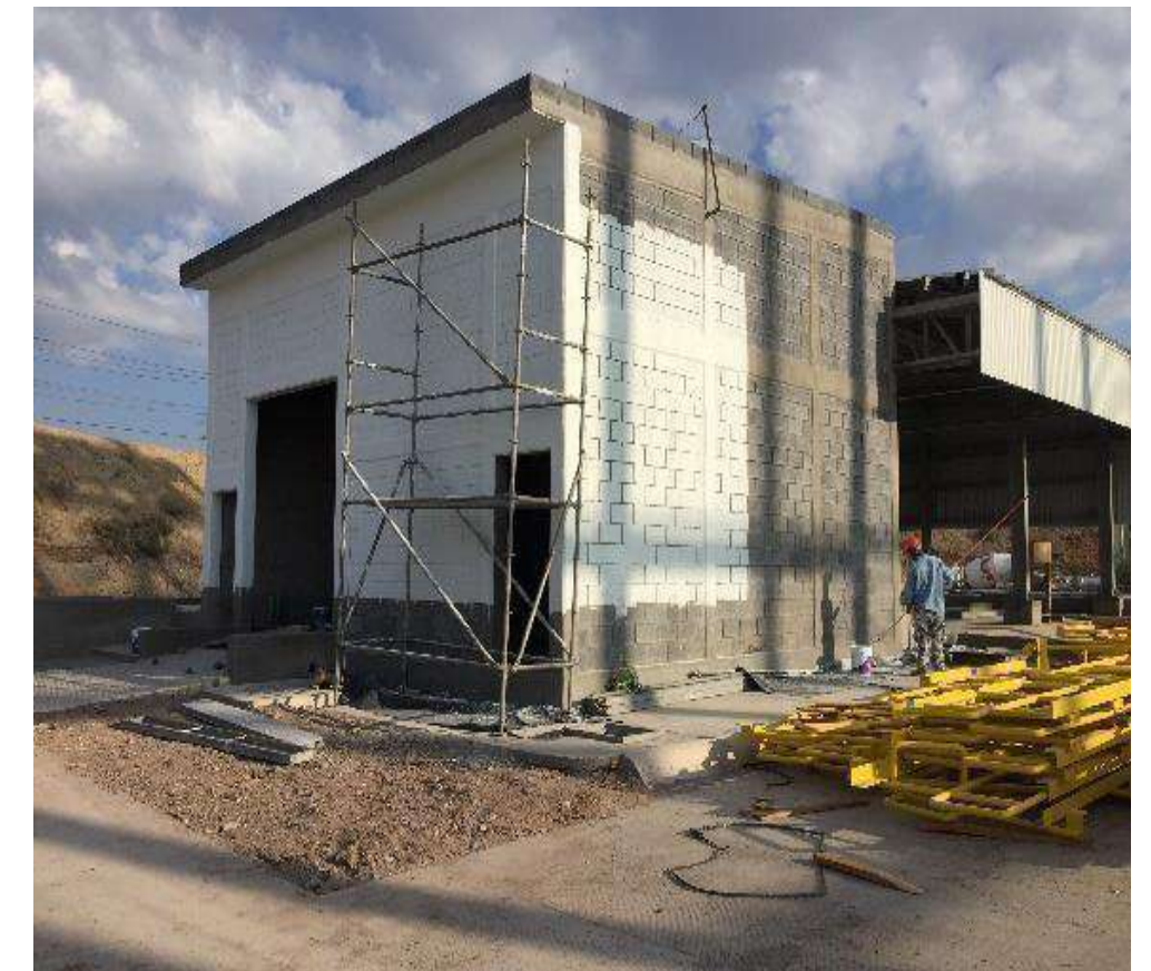
APLICACIÓN DE PINTURA Y SELLADO EN MUROS
